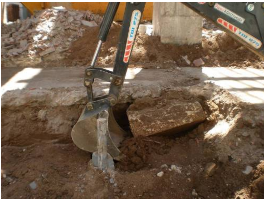
Foto 8: Retirada mecànica de la doçella procedent de la UE 3
