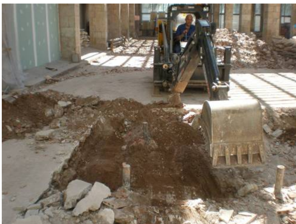
Foto 6: Excavació mecànica de l'estrat d'anivellament UE 3
