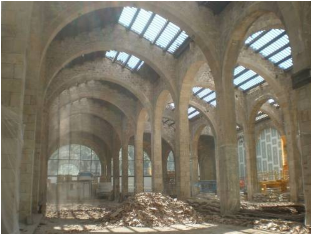
Foto 4: Aspecte de la nau durant les tasques de rehabilitació
