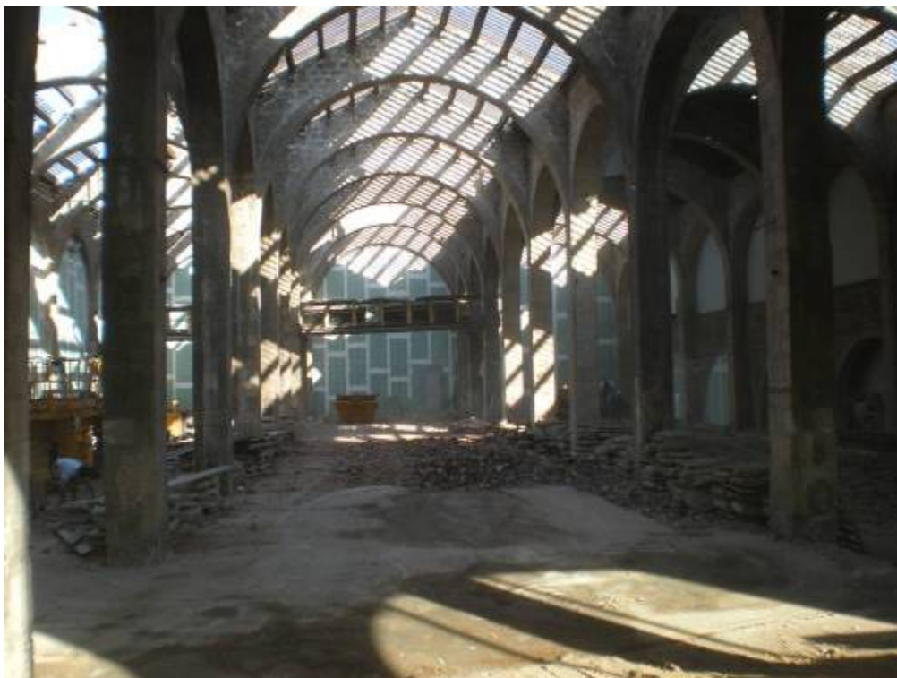
Foto 1: Inicial a les tasques d'excavació
