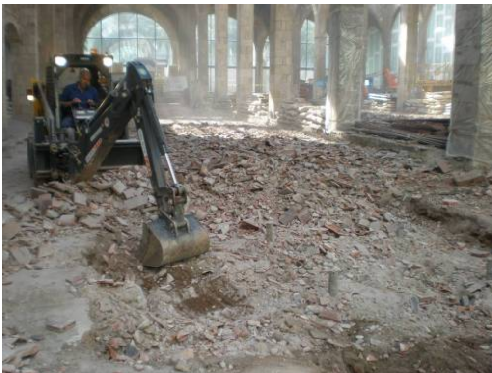
Foto 2: Retirada de material constructiu acumulat
