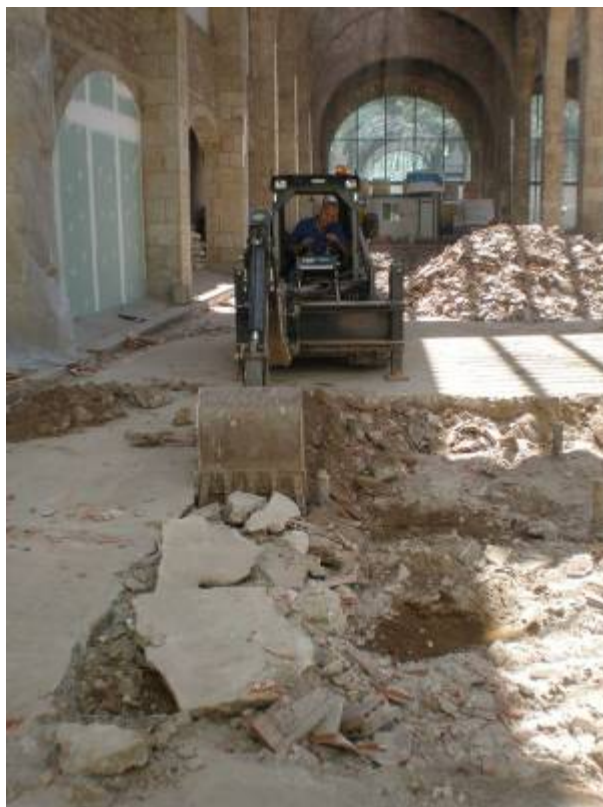
Foto 5: Demolició del morter pobre corresponent al paviment UE 2
