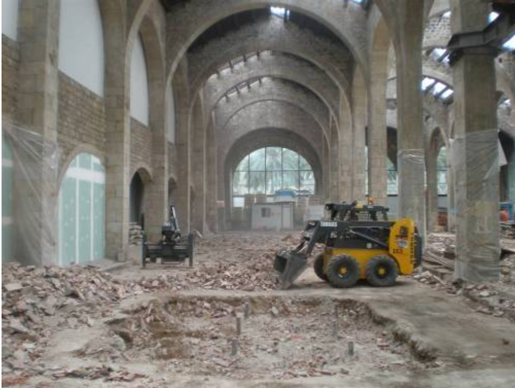
Foto 3: Retirada de material constructiu
