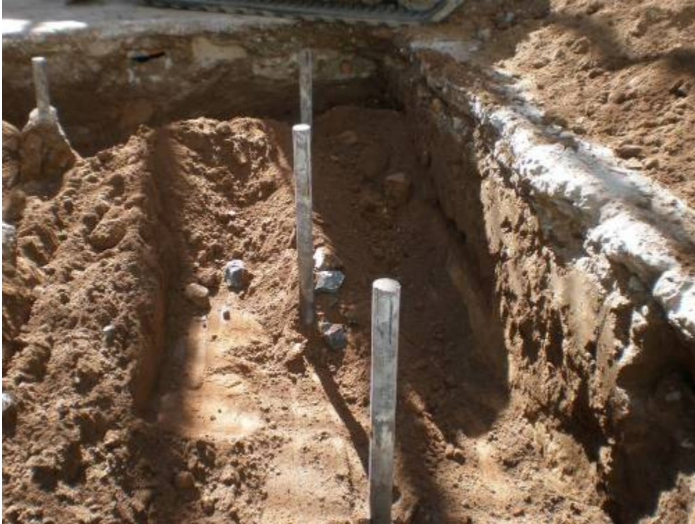
Foto 15: Excavació de la UE 8
